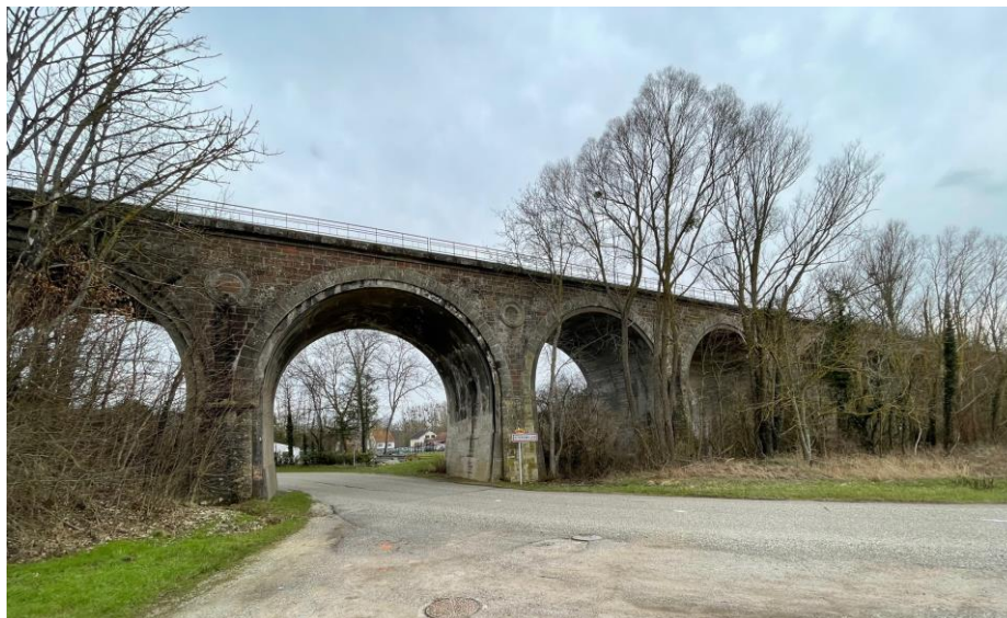
Vue d'ensemble de l'ouvrage depuis le nord-ouest
