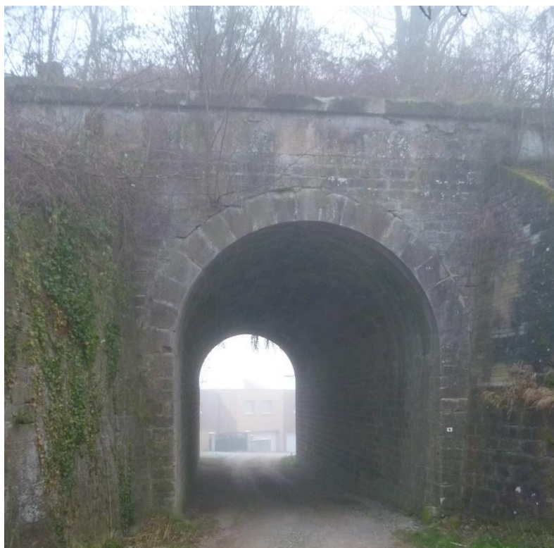
Vue d'ensemble de l'ouvrage depuis l'amont
