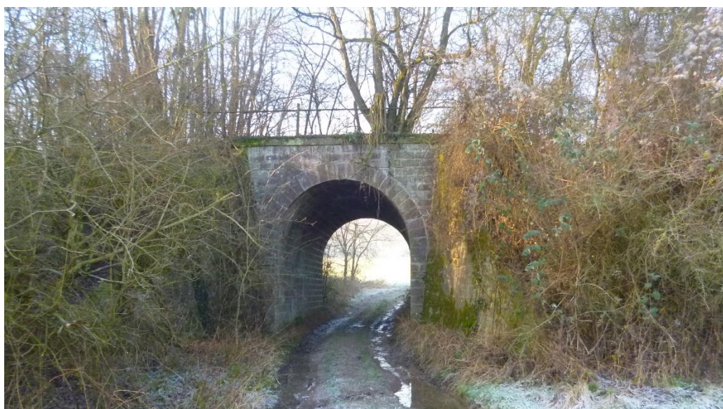
Vue d'ensemble de l'ouvrage depuis l'amont
