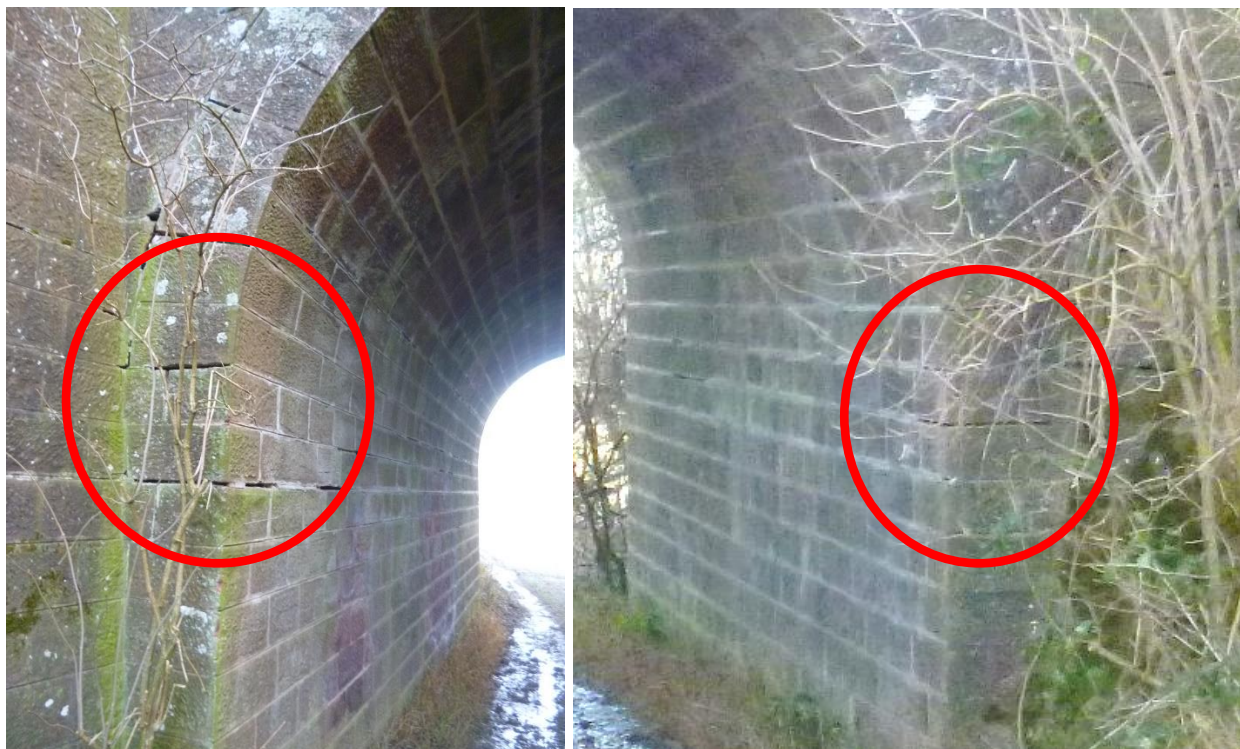
Naissance des voûtes coté Ouest
